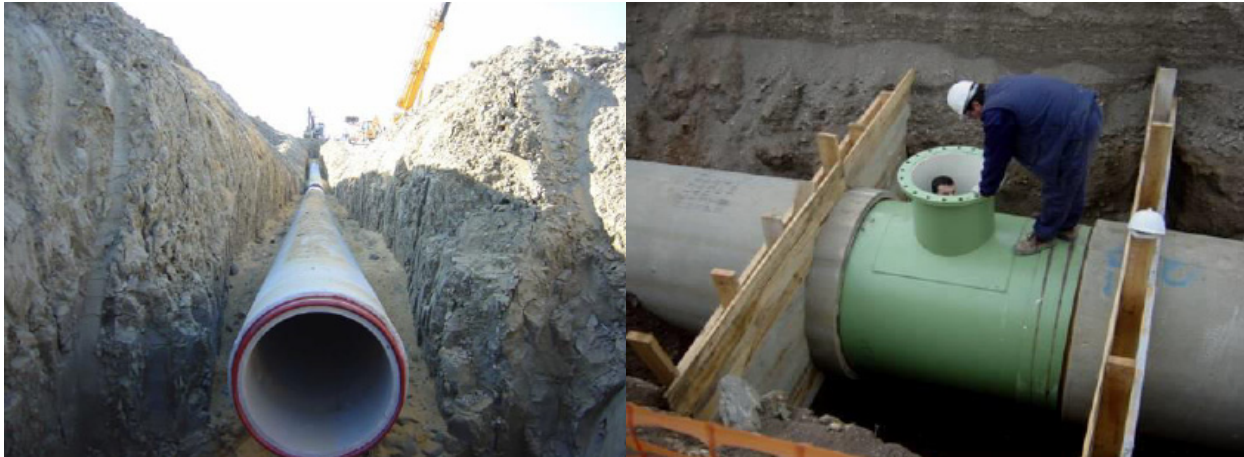
Fotografía 1. Ejemplo del sistema de instalación de las tuberías principales
